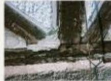
Marodes Fachwerk: Der zur "Reparatur" verwendete Zementmörtel beschleunigte noch den Verfall
