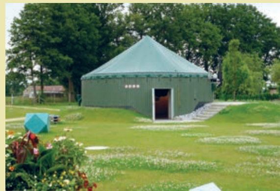
Begehbare Fermenter mit Informationen zur Produktion von Biomasse
