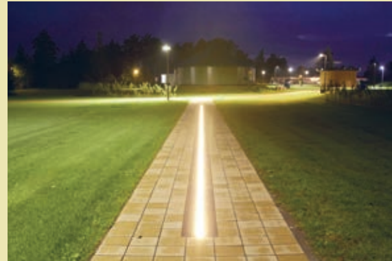
Taktiler Leitstreifen mit LED-Technologie für sehbehinderte Menschen
