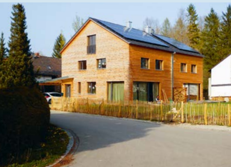
Passivhaus in Glonn
