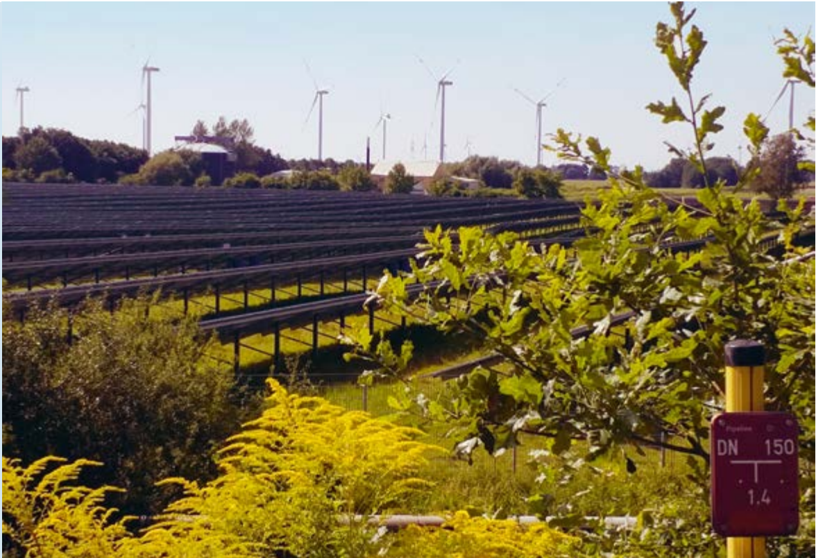
Erneuerbarer Energien-Mix: Windkraft und Freiflächen-Photovoltaik
