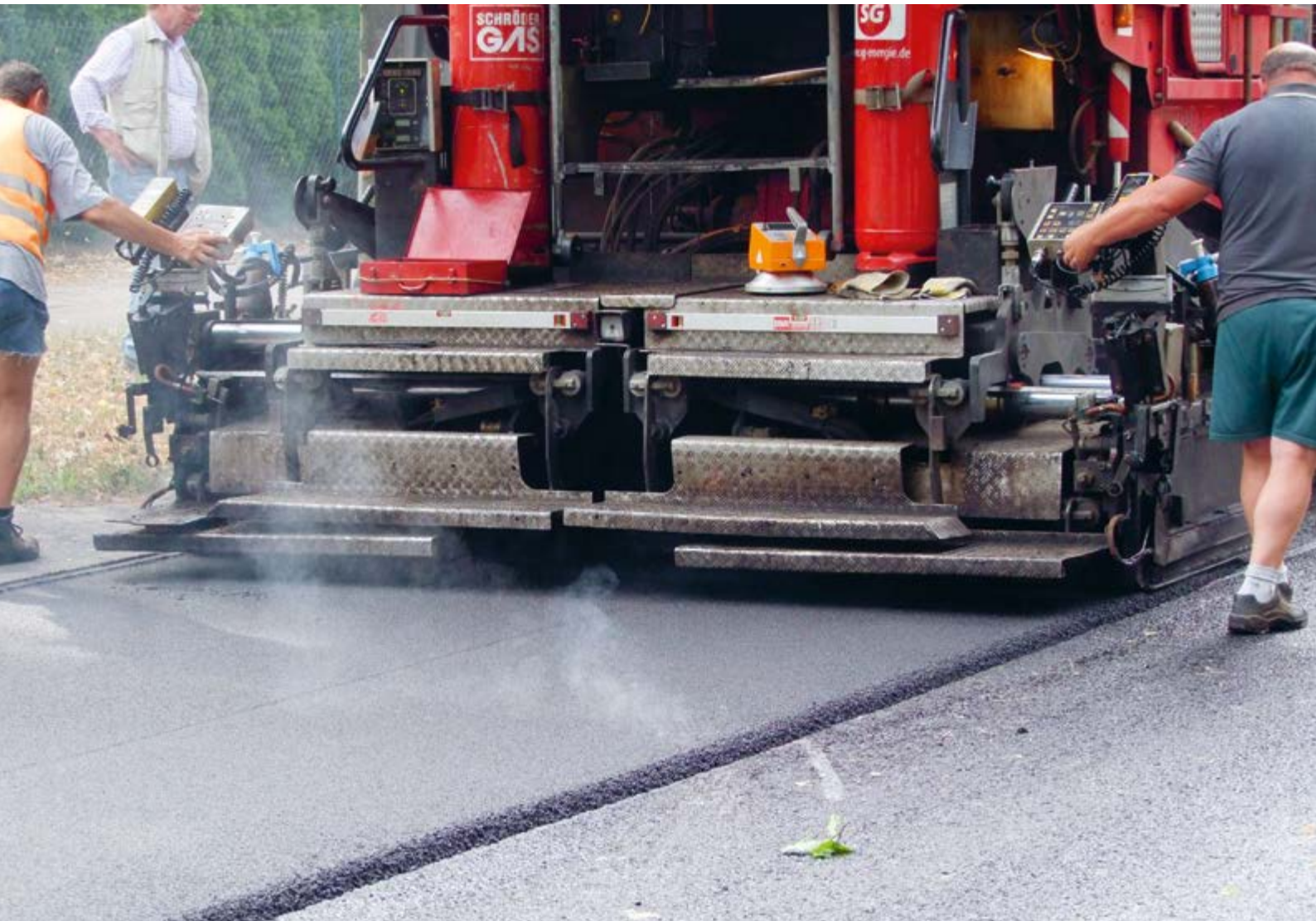
Einbringen eines lärmarmen Fahrbahnbelags
