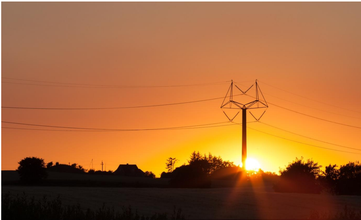
Abbildung 17: „Design-Pylon“ als alternative Mastform bei einer 400 kV-Leitung in Dänemark. Foto: Bystrup © Photo: Michel van Steenwijk.
