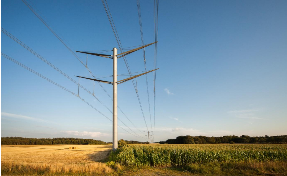
Abbildung 18: „Eagle-Pylon“ als alternative Mastform für eine 2x400 kV-Leitung in Dänemark. Foto: Bystrup © Photo: Michel van Steenwijk.
